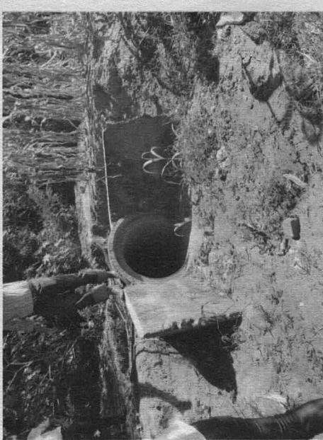
Esgoto de águas pluviais estourado e quando chove fica parada à margem do córrego
